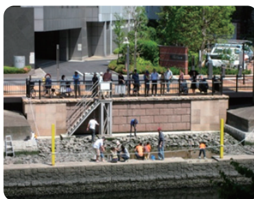
写真：国土技術政策総合研究所、 東京都、港区 生物生息に配慮した テラス型護岸（芝浦運河）
