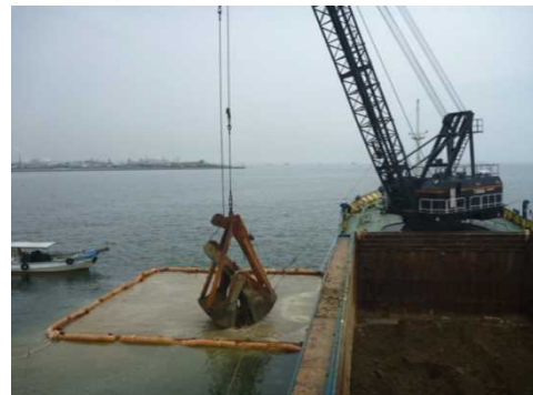
河川工事で発生した良質な土砂を活用した浅場造成の様子（たつの市地先）
