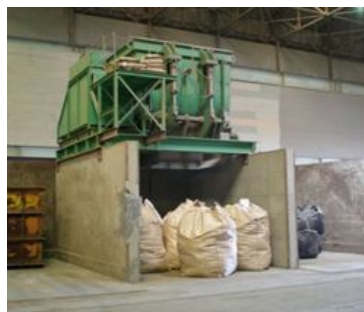
不溶化処理施設
