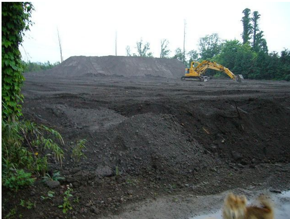
図8 大規模な残土処分場（その2）
