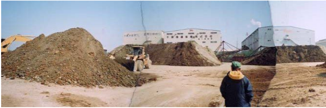
図6 船から陸揚げされた残土
