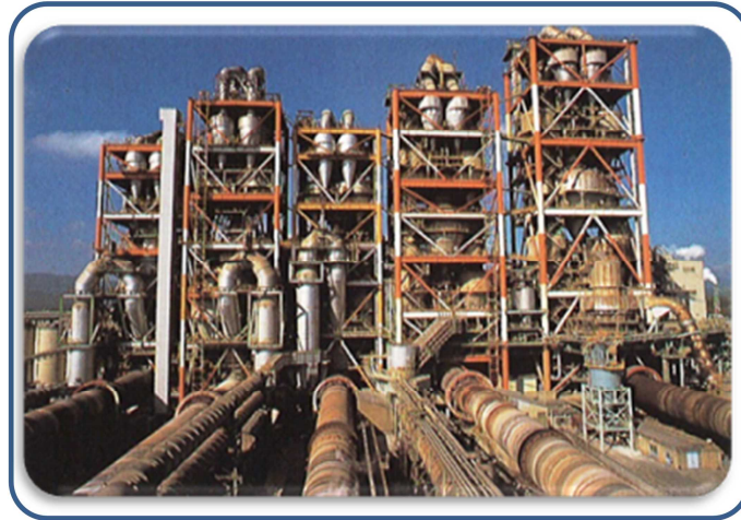
図 1.5.1-4 セメント製造施設の例
