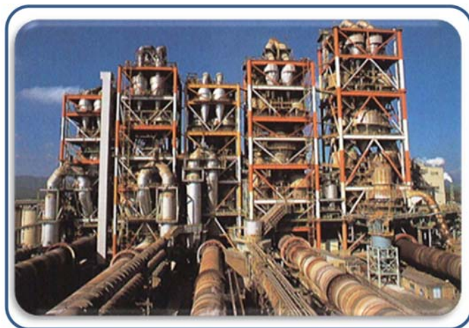
図 1.5.1-4 セメント製造施設の例
