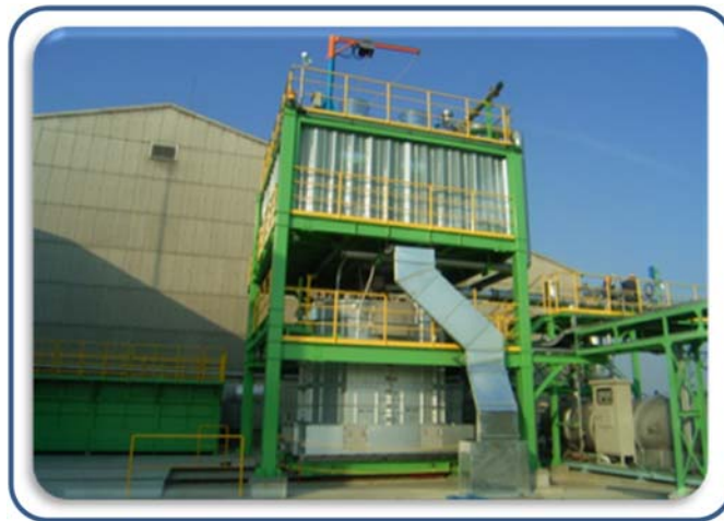
図 1.5.1-3 浄化等処理施設（溶融）の例
