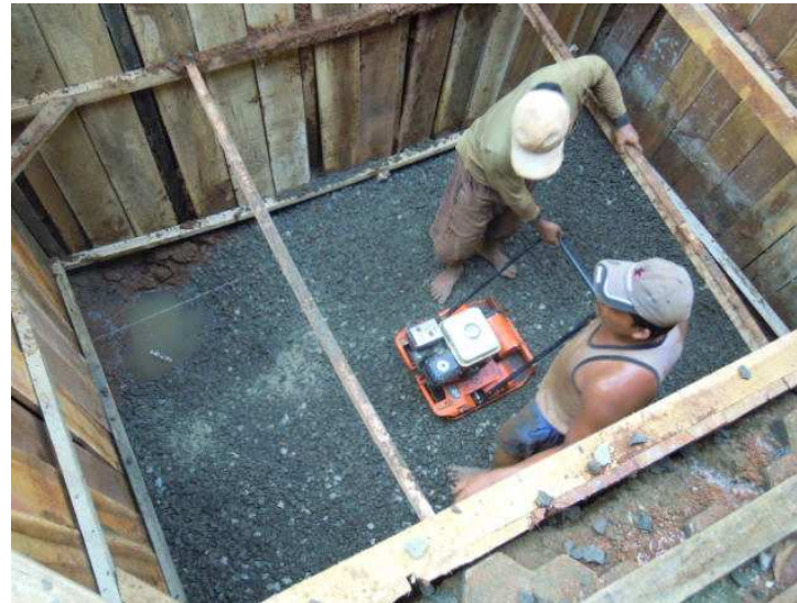
④栗石作業、突き固め
