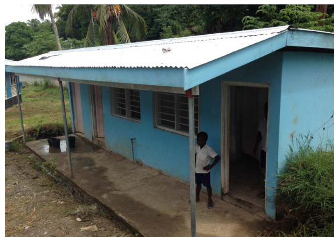
【写真35:ボコナベラ学校のトイレ】
