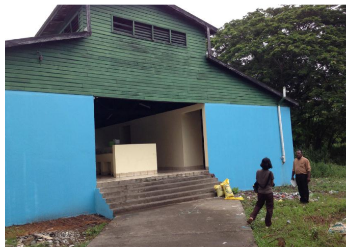
【写真33:テナル学校のトイレ】
