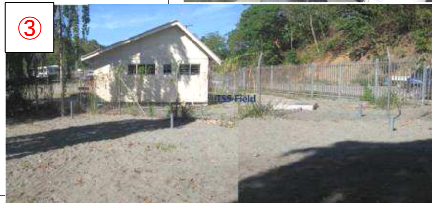
【写真7:TSS完成後の全景等】
