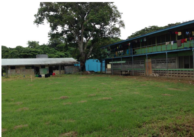
【写真32:テナル学校】女子寮トイレの処理設備不備改善を要望。
