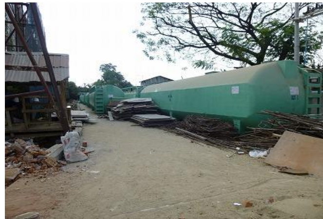
ヤンゴン市内のホテルの建設現場
