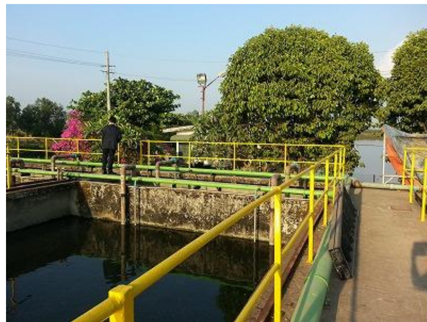
工業団地の集中排水処理施設
