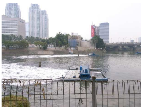
インドネシア・ジャカルタ市 (4.5万m 3 /日、酸化池)
