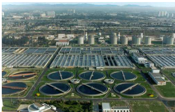
中国・北京市 (100万m 3 /日、活性汚泥法)
