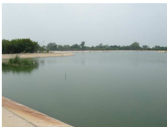
タイ・スパンブリー県 (1.1万m 3 /日、安定化池)
