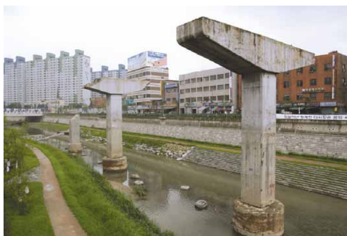
【写真6】残された3本の橋脚
