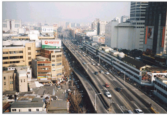
【写真4】清溪高架道路
