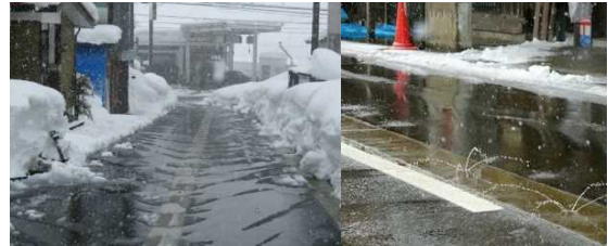
写真1 散水消雪施設
