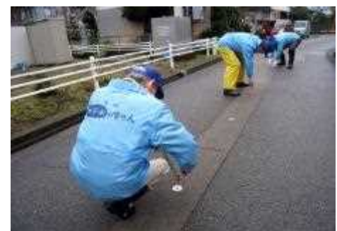
写真 1 地下水の守り人による散水ノズルの点検 2)
