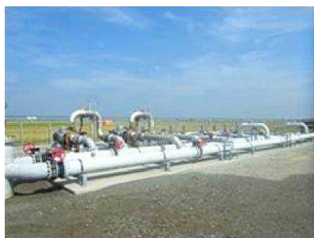
写真 1 かん水圧入基地 1)
