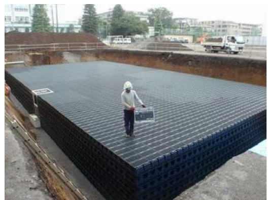
写真3 雨水貯留浸透施設（武蔵野市） 4)
