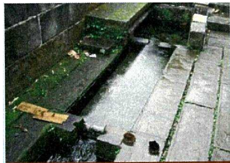
写真 1 住民により清掃された湧水
