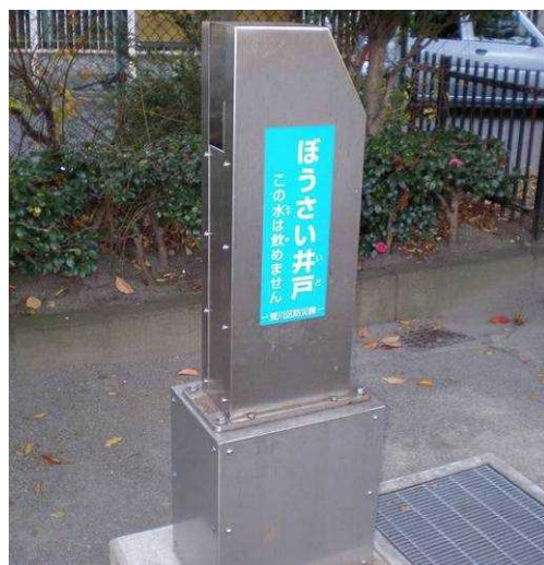
写真 1 防災井戸の例（荒川区）
