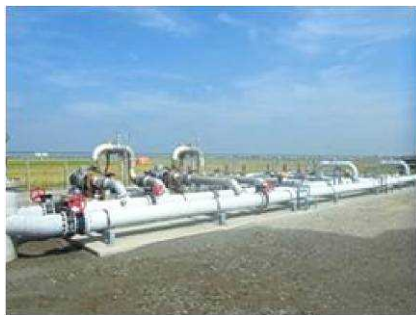
写真 1 かん水圧入基地 1)
