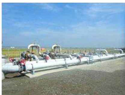
写真 1 かん水圧入基地 1)
