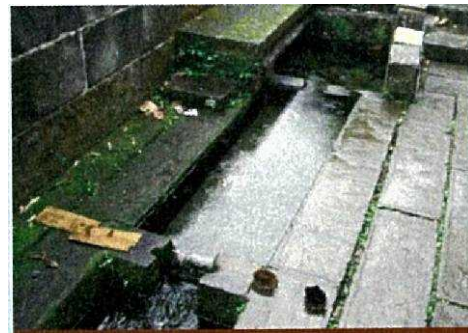
写真1 住民により清掃された湧水
