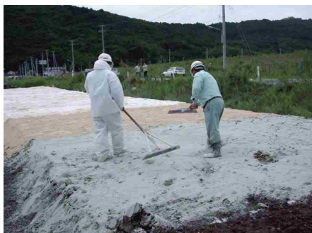
不溶化処理（改良材の散布）
