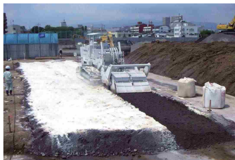
不溶化処理（スタビライザーによる混合）
