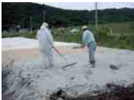
不溶化処理（改良材の散布）
