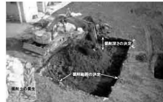
図 4-13 掘削除去の概況写真
