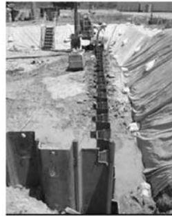
図 8-19 遮水壁（鋼矢板）の打設状況
