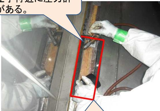
床の継ぎ目部に石鹼液を塗布し、枠内を吸引する。漏れがあれば気泡が出る。
