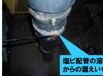
塩ビ配管の溶着部分からの漏えいを確認
