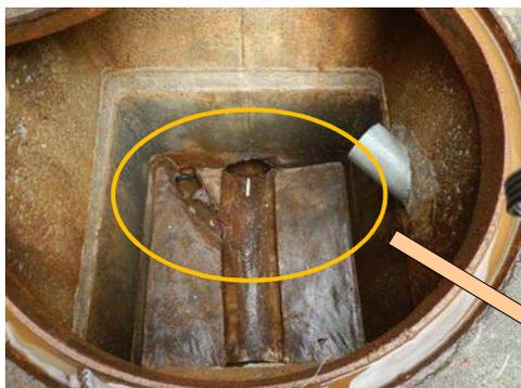
塩ビとコンクリートの擦り付け部分が侵食され、漏水が生じている状態
