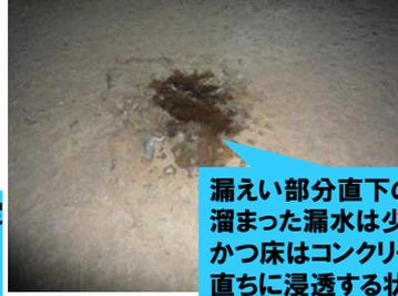
漏えい部分直下の床面。溜まった漏水は少量であり、かつ床はコンクリートのため直ちに浸透する状況でない。
