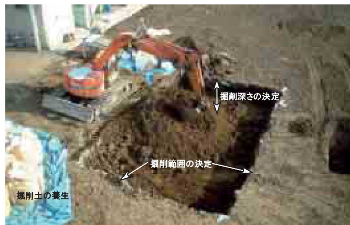
図 8-14 掘削除去の概況写真
