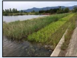
底質改善対策（覆土工・植生工）
