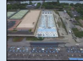
湖南中部浄化センター（令和元年6月増設）
