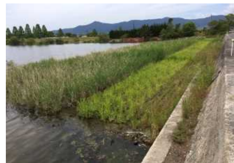
底質改善対策（覆土工・植生工）
