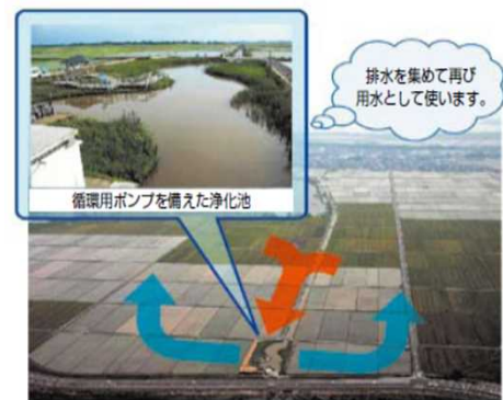
循環かんがい施設(木浜地区)
