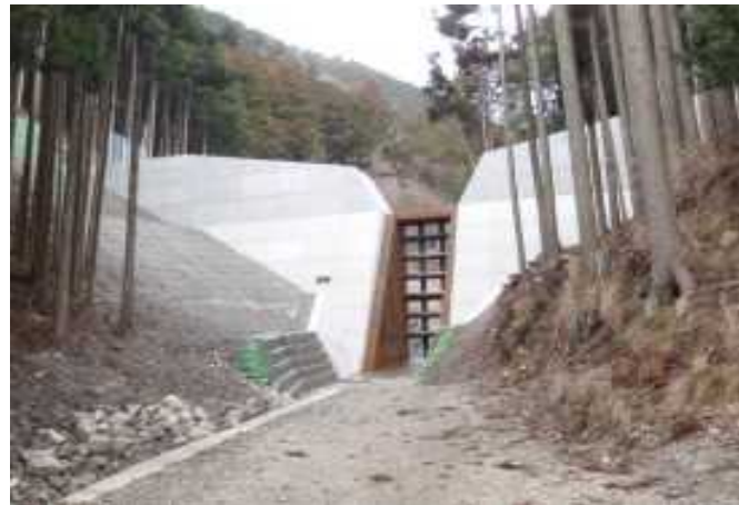
日野谷川堰堤（甲賀市）
