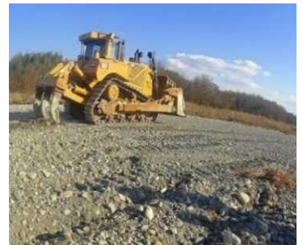
細粒分の流下促進によるアユの産卵環境の改善のための愛知川固定化砂州におけるアーマーコート破壊（河床耕耘）事業
