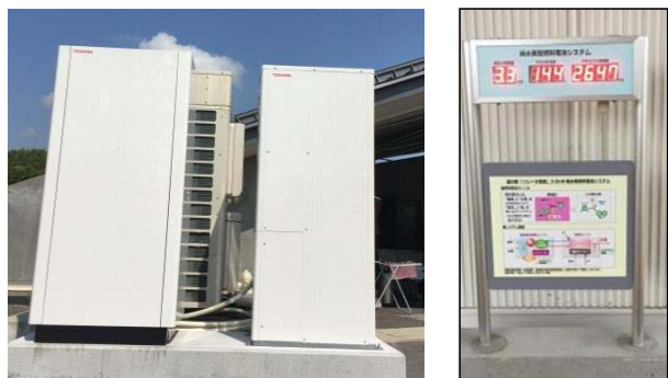
カードルで輸送した圧縮水素ガスの供給による 3.5kw純水素燃料電池の実証開始 (28年3月)
