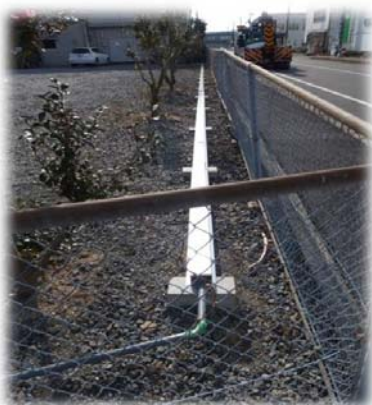
公道水素配管
