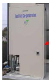
一般家庭に設置された水素供給燃料電池 (貯湯タンク一体型)
