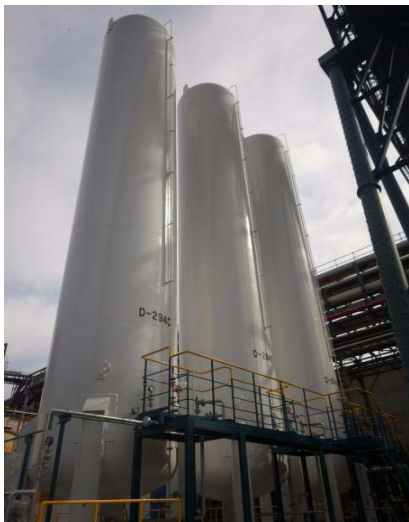
未利用水素回収用のバッファドラム設置 (28年10月)
