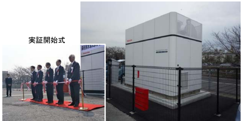
100kw純水素燃料電池の設置、苛性ソーダ工場からの供給配管による未利用副生水素の直接供給開始 (29年3月)
