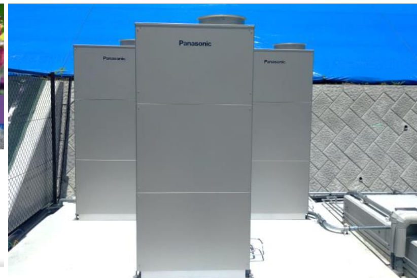
出力15kW(5kW×3台) 純水素型燃料電池
