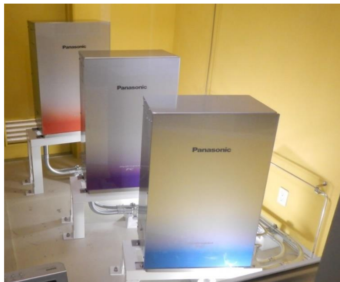
出力2.1kW(700W×3台) 純水素型燃料電池
