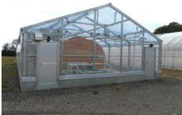
余剰熱供給施設建屋
