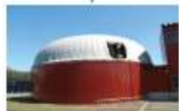
既存メタン発酵施設
