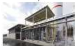
② 水素製造装置
