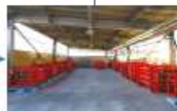
① カードル充填場
