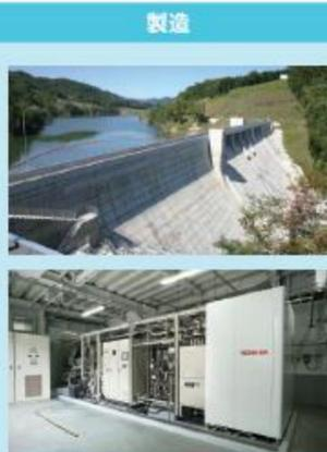
小水力発電所の電力を用いて、水素を製造
