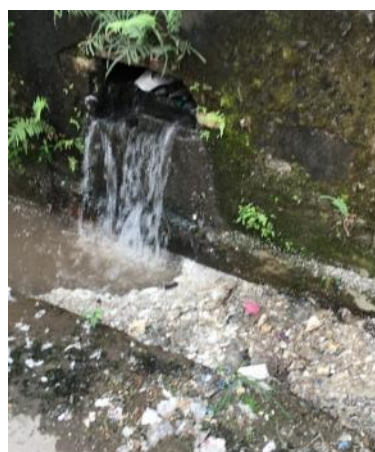
リサイクル施設からの排水
