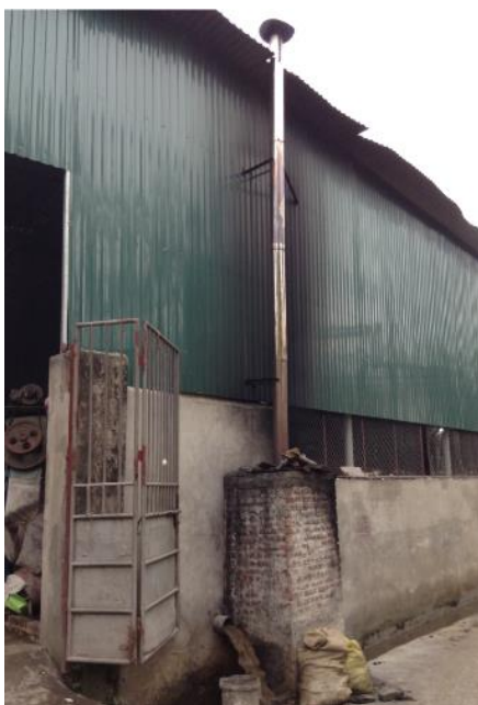
プラくずリサイクル工場の煙突
