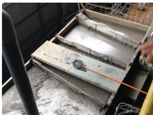
排水処理施設
