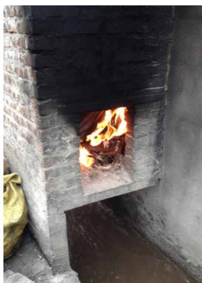
プラくず工場の簡易焼却炉
