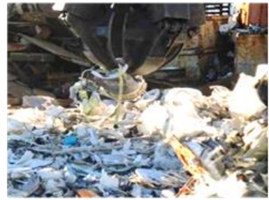
重機による洗濯機の破碎
