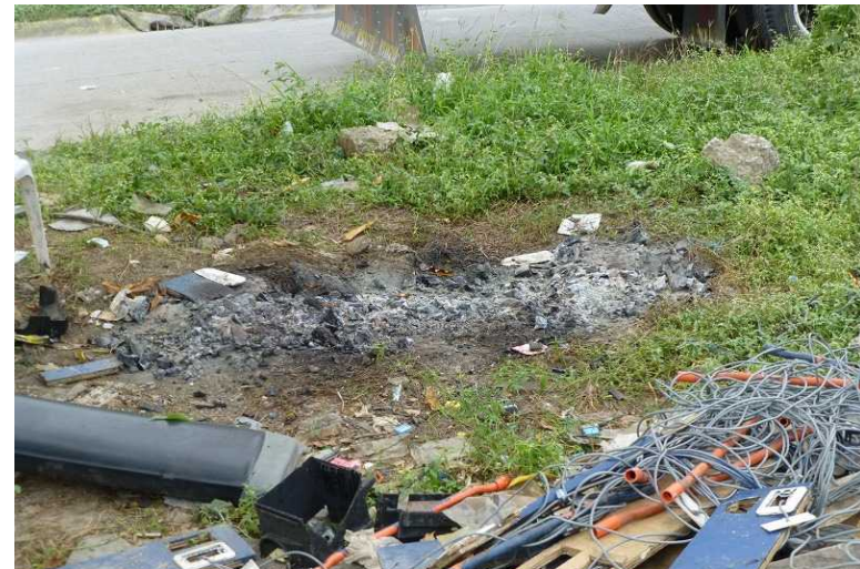
銅回収のためのケーブルの野焼き跡が散見された。
