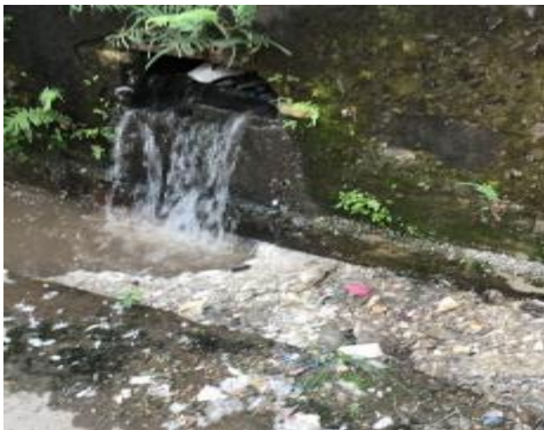
<リサイクル施設から放流される未処理の排水>
