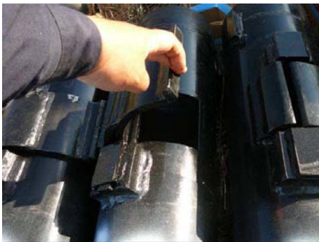
写真 3-9 サンプリング用鋼管ケーシング
