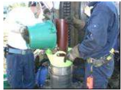
写真 3-5 充填材投入状況
