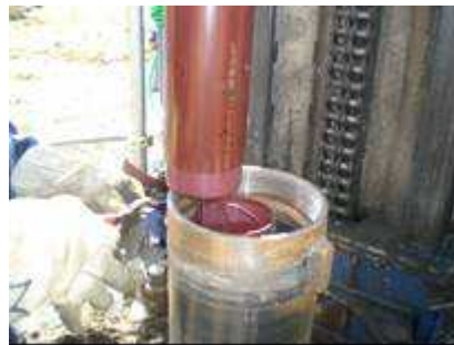
写真 3-4 ジョイント状況
