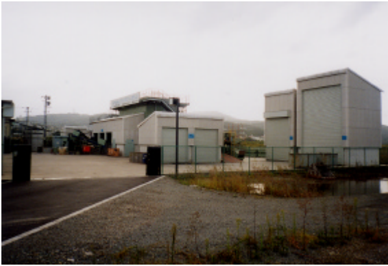
写真-1 前処理施設全景
