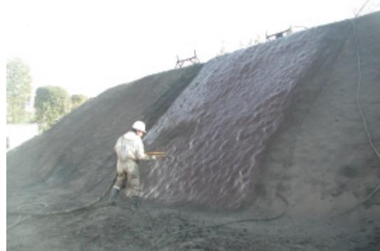
写真 - 3 マスチック層の施工状況
