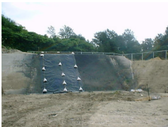
写真 - 1 試験施工後の遮水層
