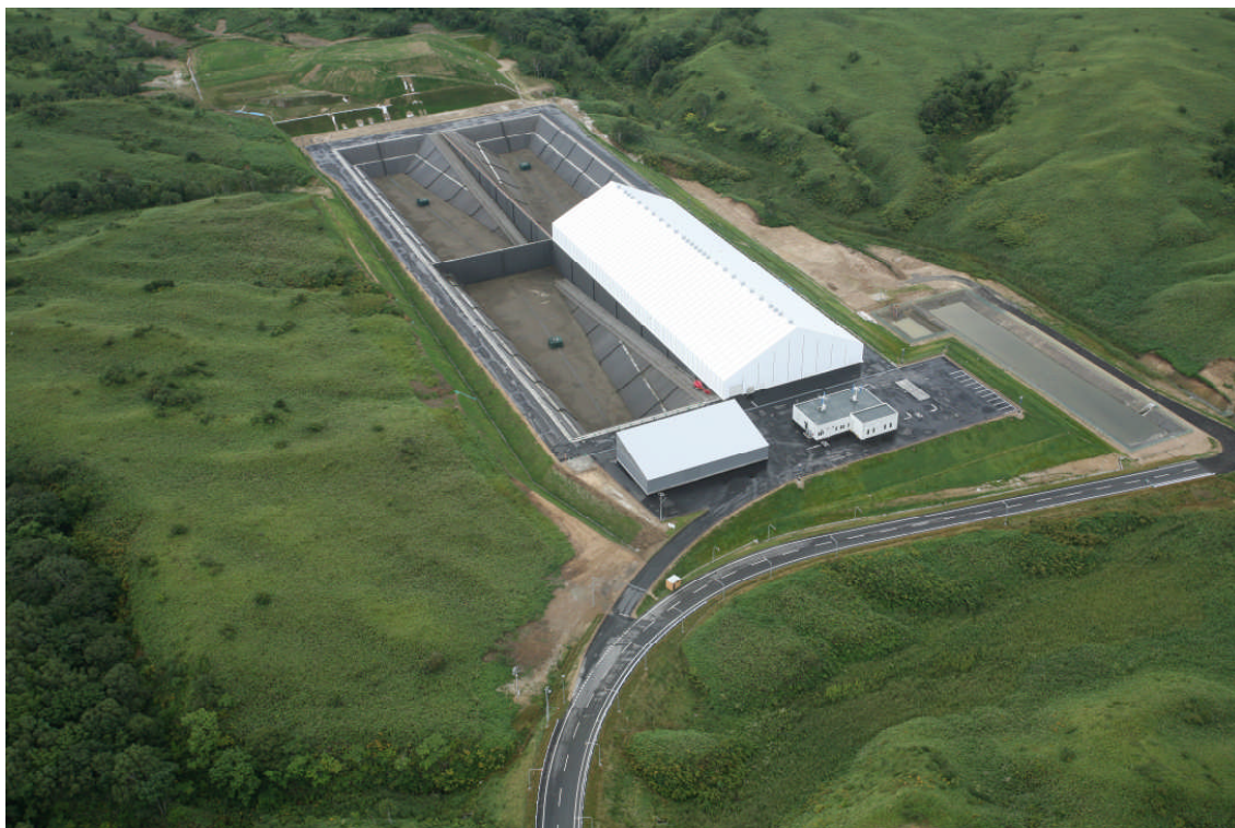
稚内市廃棄物最終処分場外観（稚内市提供）
