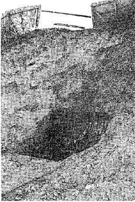
図 7-6 廃石綿等の埋立用穴
