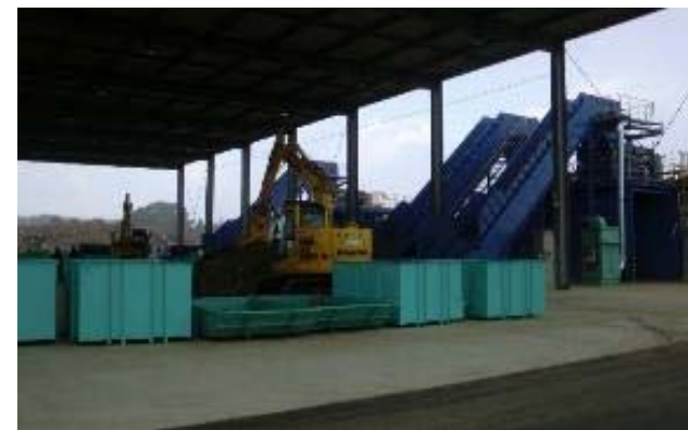
県二次仮置場に設置されている選別装置
