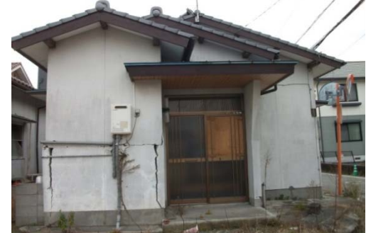
建物壁面・基礎の損壊で全壊とされる例
