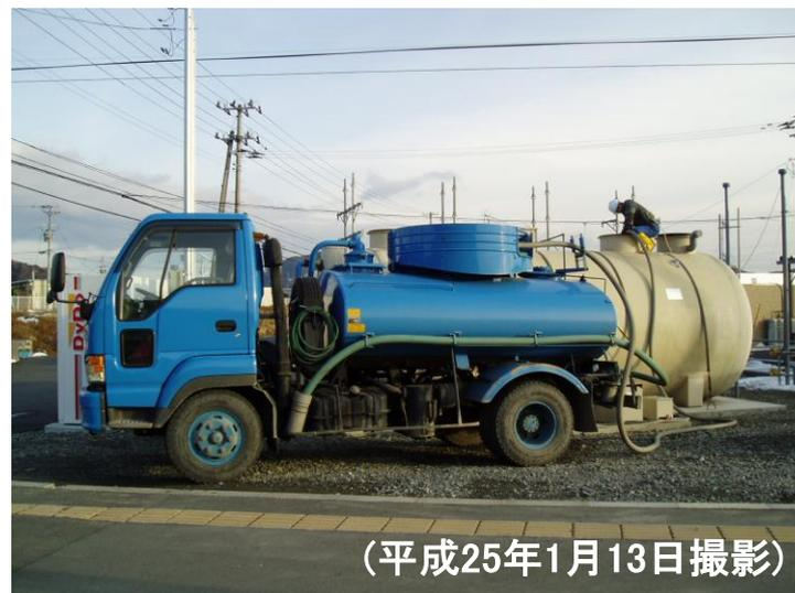
応急仮設住宅浄化槽の清掃作業(足場・昇降設備・点検歩廊が無い場合非常に危険)
