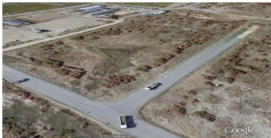
井土搬入場造成状況
