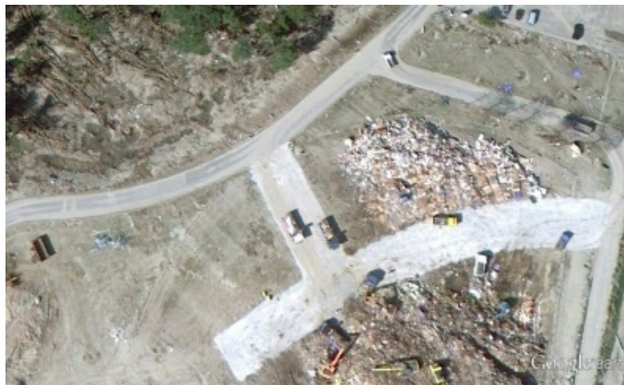
蒲生がれき搬入場造成状況
