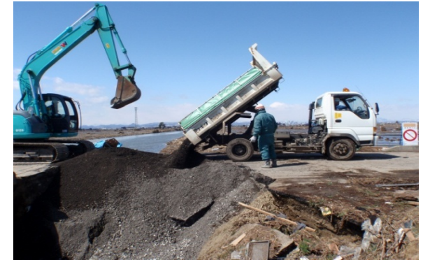
道路橋の復旧: 県道塩釜亘理線
