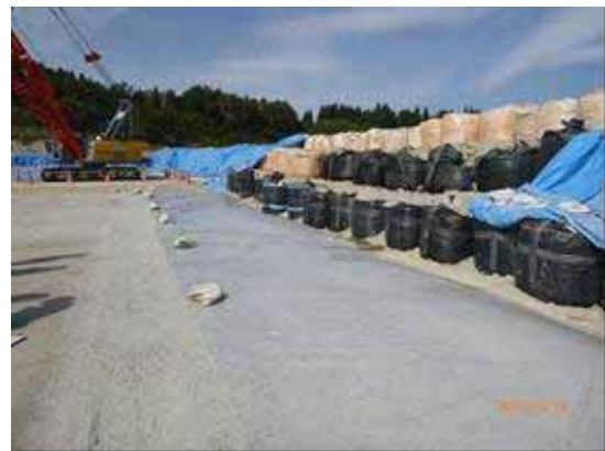
土壌層敷設後の飛灰の埋立作業
