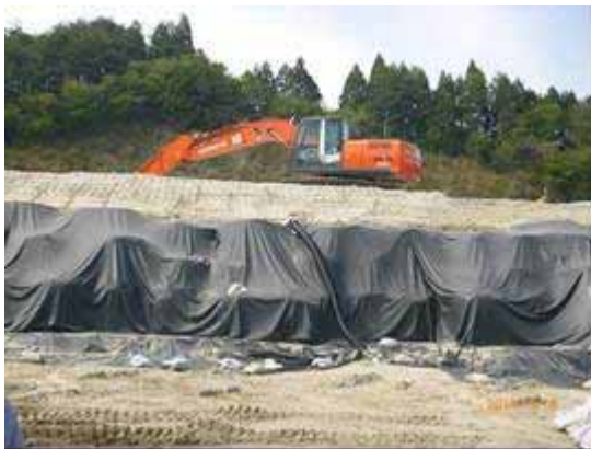
小鶴沢処分場（宮城県黒川郡大和町）
