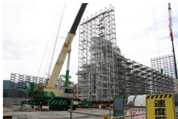
解体中(撮影日H25.9.26)
