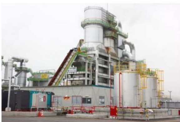
解体前(撮影日H25.5.16)
