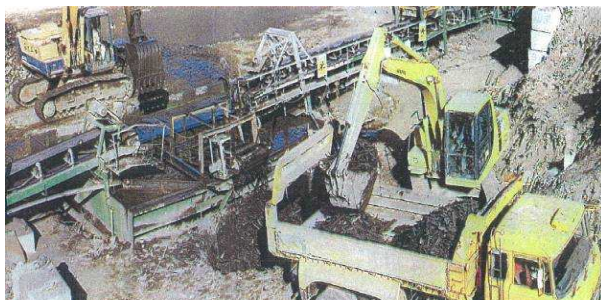
水槽分離施設での作業の様子
