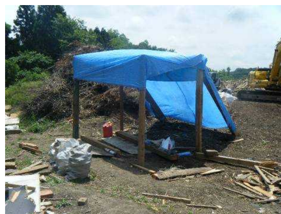
作業現場付近に設けられた休息所 (柱はガレキの一部を有効利用)
