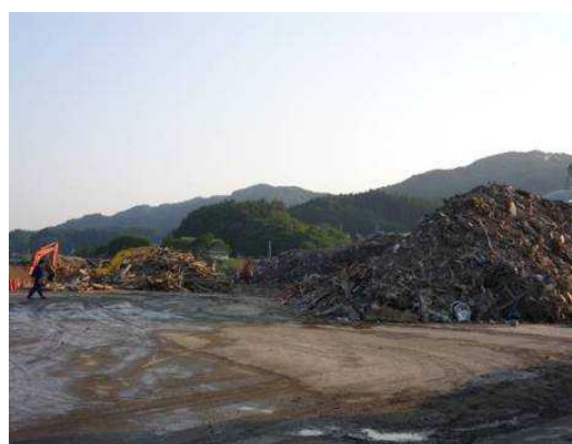
ヤード毎に確保された作業スペース
