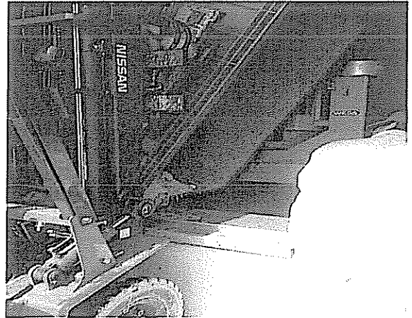
(2) パイプロの投入
