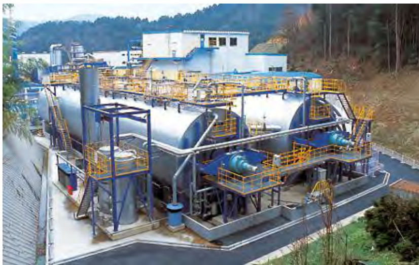
図 1.2-20 タクマ 乾式メタン発酵槽（50t/日） 施工例 （出所）株式会社タクマ ホームページ
