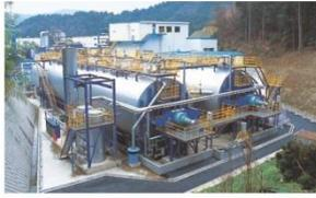
乾式メタン発酵（50t/d・発酵槽2層）
