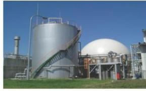
湿式メタン発酵槽（40t/d・発酵槽2層）
