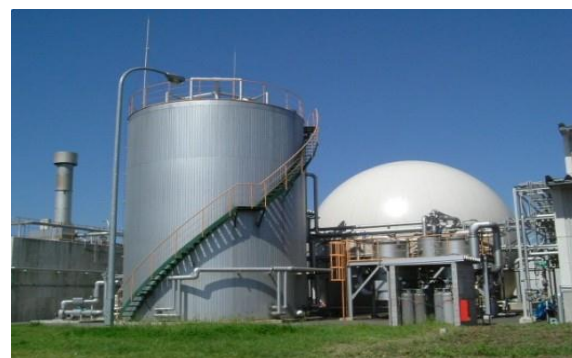
湿式メタン発酵槽（40t/d・発酵槽2槽） （出所）富山県 ホームページ
