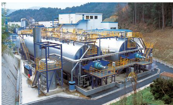
乾式メタン発酵（50t/d・発酵槽2槽） （出所）株式会社タクマ ホームページ
