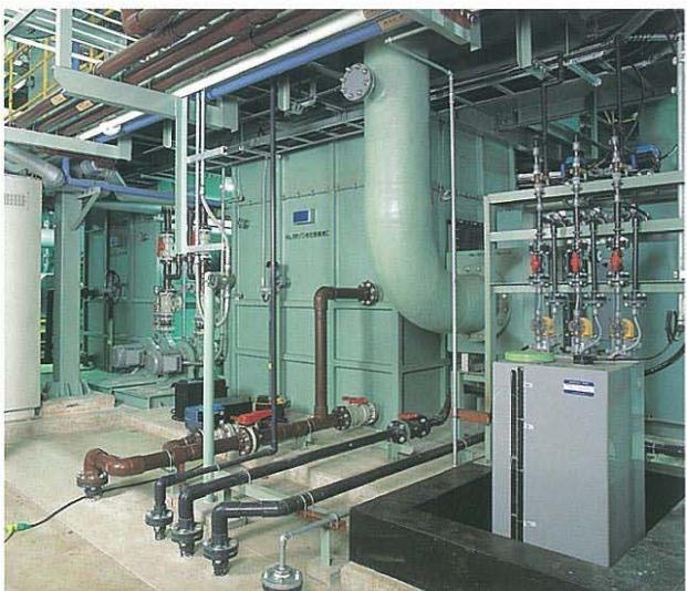
■排ガス脱臭装置(湿式オゾン酸化方式+活性炭吸着方式)
